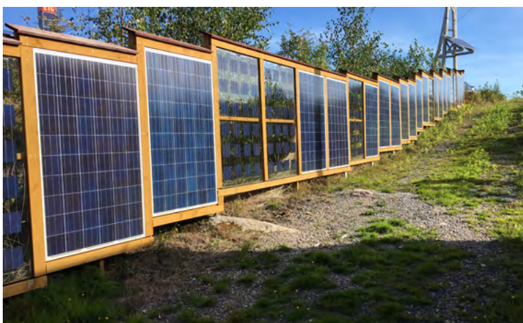
Solcellspaneler som staket/bullerplank i Katrineholm. Bild: Sanna Nilsson, WSP
