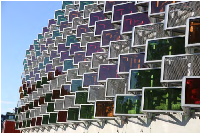
Till vänster: Färgade och semi-transparenta solcellspaneler på parkeringshuset Flustret, Linköping. Bildkälla: SanktKors. Till höger: Röd semi-transparent solcellsfasad. Plats: Simrisbanvägen, Malmö. Bildkälla: Charlotta Winkler, WSP.
