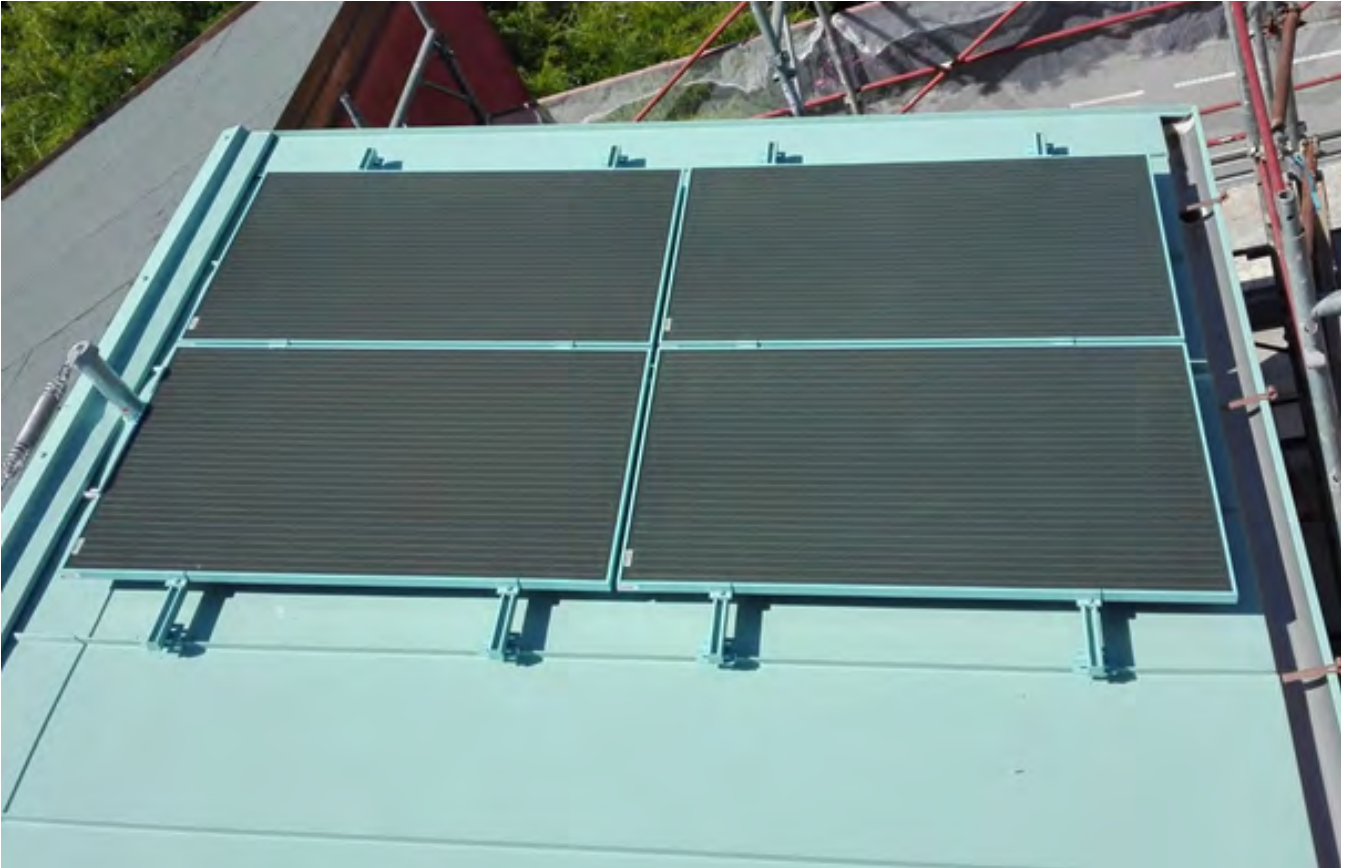
Monokristallina kiselsolcellspaneler med grönt frontglas, och koppargröna detaljer samt montagesystem.
