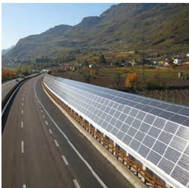
Solcellspaneler som bullerplank. Sammanfattning av projektet: Solceller – integration i transportsystem. Uppsala universitet/ÅF infrastructure 2018.
