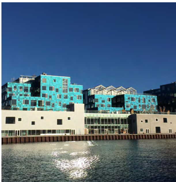
Byggnadsintegrerade solcellspaneler som utgör en skimrande fasad med olika vinklar. Copenhagen International School, Nordhavn Danmark.
