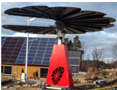
Till vänster: Solföljaren Smartflower på ETC Solpark i Katrineholm. Bild: ETC I mitten: Solcellsblomma sed framifrån. Plats: ETC, Katrineholm. Bildkälla: WSP Till höger: Släpvagn med solcellspaneler monterade. Bildkälla: Solcellsproffsens facebookside.
