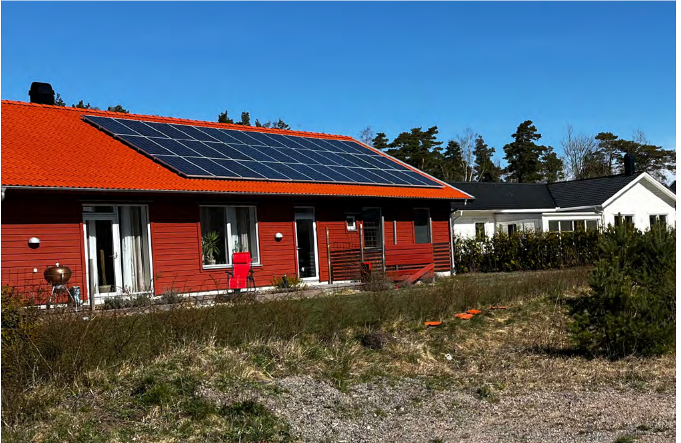
Två hus i Falkenberg med utanpåliggande solcellsanläggningar. Huset i förgrunden har utmärkande blåskimrande polykristallina kiselcellspaneler med aluminiumramar på sitt röda tak. Det bortersta huset har helsvarta monokristallina kiselcellspaneler som knappt går att urskilja på sitt svarta tak. Bild: Hampus Nyman, WSP
