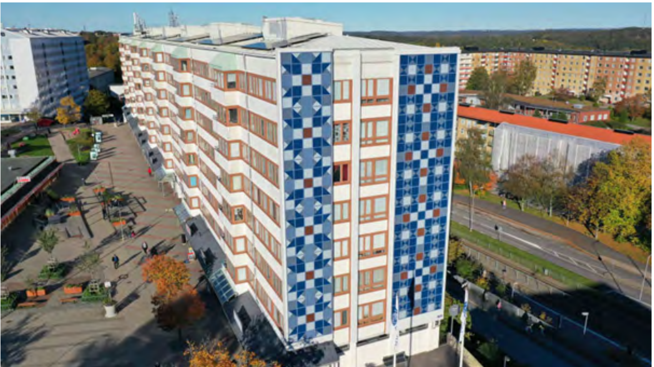
Solcellsfasad som utgörs av färfärgade solcellspaneler med mosaikmönster. Biskopsgården, Göteborg. Bildkälla: Bostadsbolaget.
