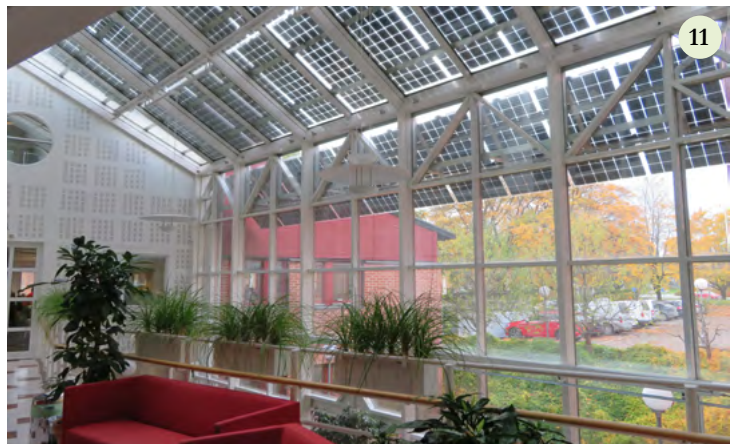
5 Horisontella och vertikala lameller av solcellspaneler som solavskärmning. Bildkälla: Colt.
