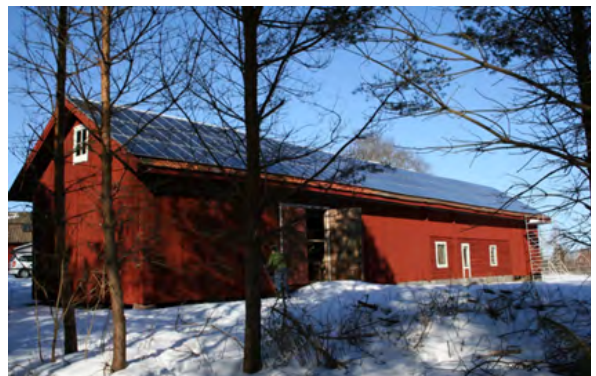
Utanpåliggande solcellspaneler på ladugårdstak, Fläckebo prästgård. Bildkälla: Svenska kyrkan.
