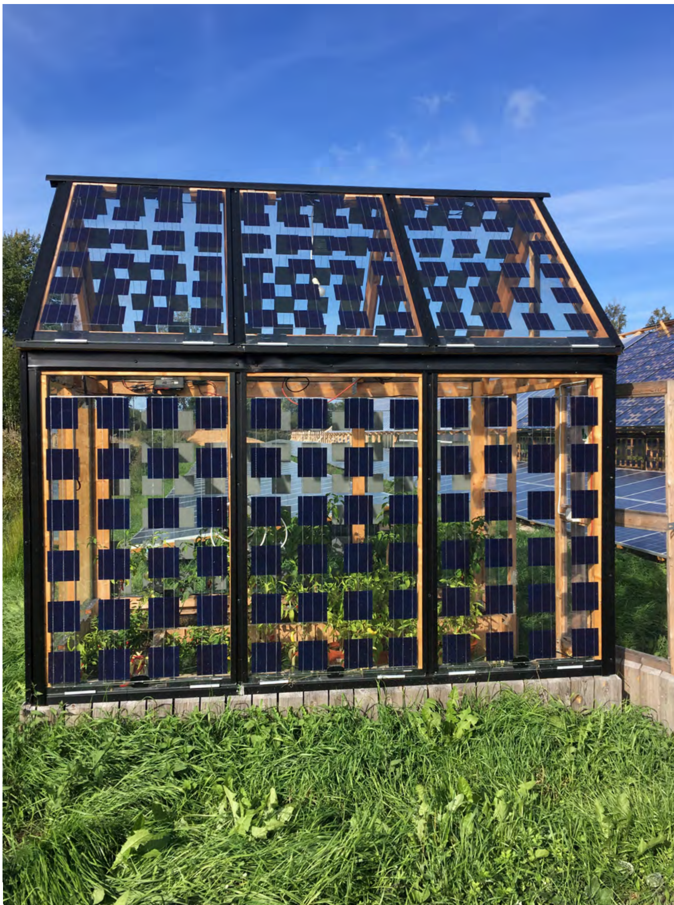
Växthus med semi-transparenta solcellspaneler integrerade i tak och fasad. Plats: ETC, Katrineholm Katrineholm. Bildkälla: WSP.
