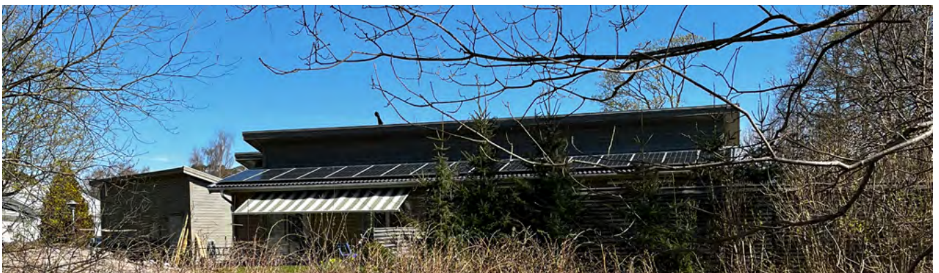
Mindre solcellsanläggning som är anpassad efter hushållets elbehov och byggnadens utformning. Bild: Hampus Nyman, WSP
