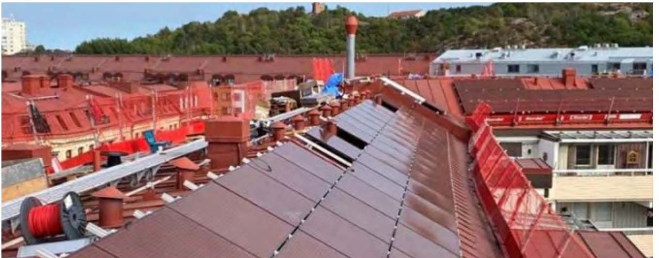
Röda monokristallina kiselcellspaneler på rött falsat plåttak i Linné i Göteborg.
