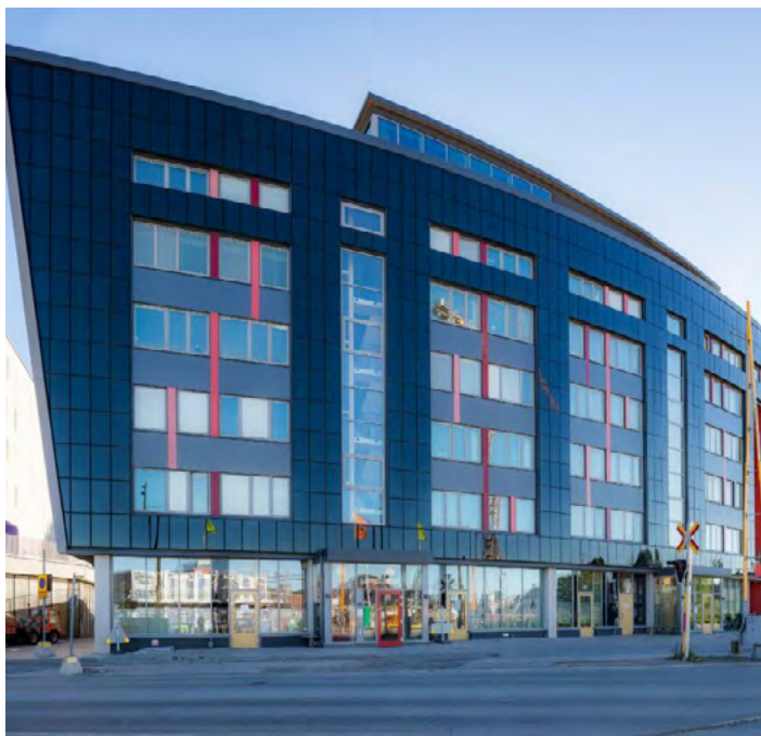
Solcellsfasad på en välvd bostadsbyggnad i Frodeparken, Uppsala. Bildkälla: White arkitekter.
