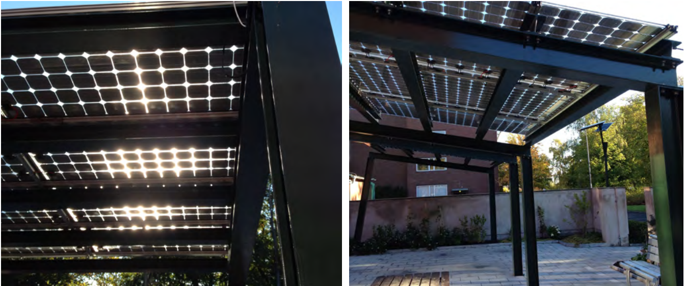
Terrasstak utgjort av semi-transparenta solcellspaneler. Plats: Simrisbanvägen, Malmö. Bildkälla: Charlotta Winkler, WSP.
