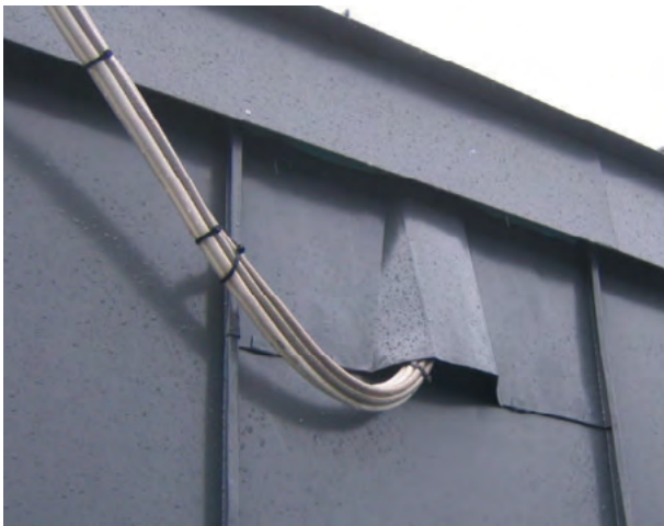
Genomföring på fasad av falsad plåt. Foto: Torbjörn Österling
