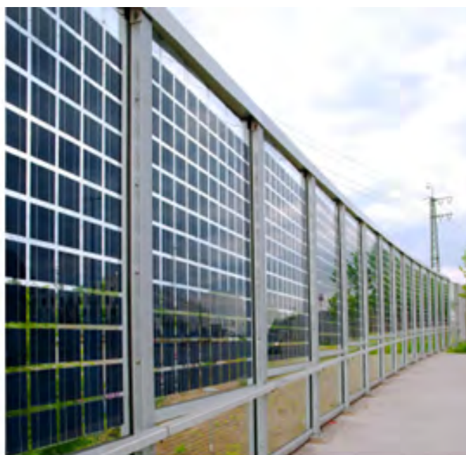
Solcellspaneler som bullerplank. Sammanfattning av projektet: Solceller – integration i transportsystem. Uppsala universitet/ÅF infrastructure 2018.
