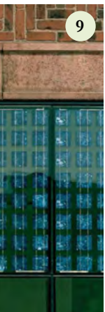
4 Solcellspaneler ovanför fönster samt fönsterluckor med integrerade solcellspaneler som solavskärmning. Nechlin, Tyskland. Bildkälla: Thomas Franz, Phönix Contact. IEA-PVPS TASK 15.
