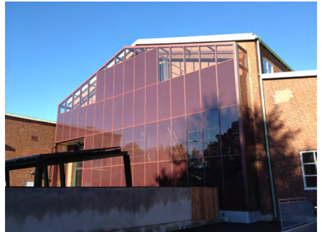
Till vänster: Färgade och semi-transparenta solcellspaneler på parkeringshuset Flustret, Linköping. Bildkälla: SanktKors. Till höger: Röd semi-transparent solcellsfasad. Plats: Simrisbanvägen, Malmö. Bildkälla: Charlotta Winkler, WSP.
