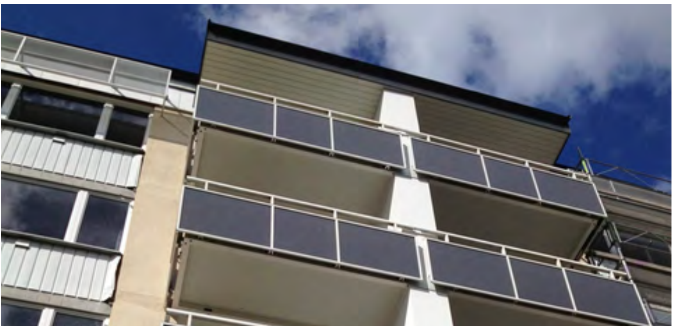
Balkongräcken med integrerade solcellspaneler, plats okänd. Bildkälla: Light Energy Consulting AB.
