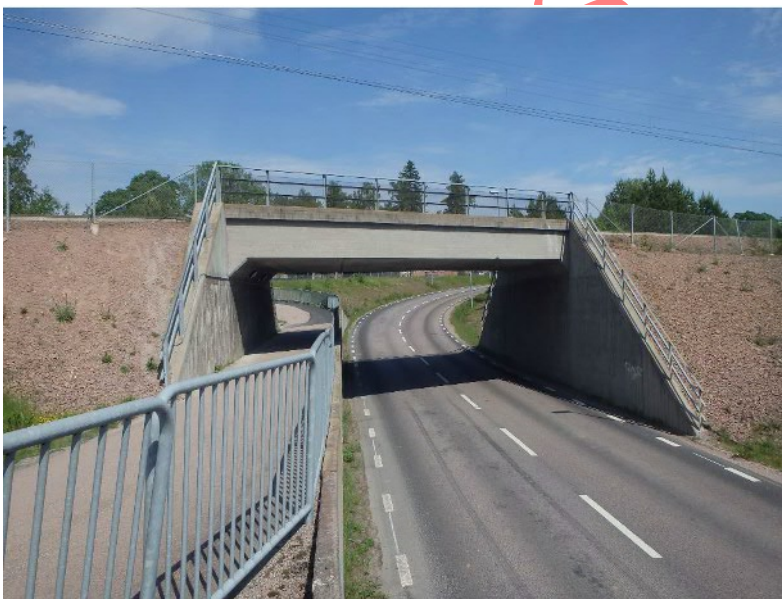
Figur 14 BaTMan ID: 3500-4789-1, järnvägsbro, km 136+197, byggd 1950
