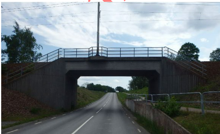
Figur 26 BaTMan ID: 3500-4791-1, järnvägsbro, km 337+693, byggd 1996
