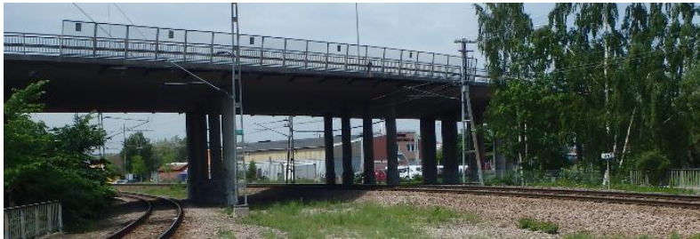
Figur 20 BaTMan ID: 19-388-1, vägbro, ca km 344+966, byggd 1966
