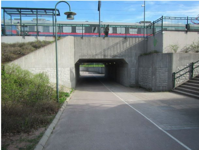
Figur 10 BaTMan ID: 3500-5472-1, järnvägsbro, km 130+151, byggd 2006
