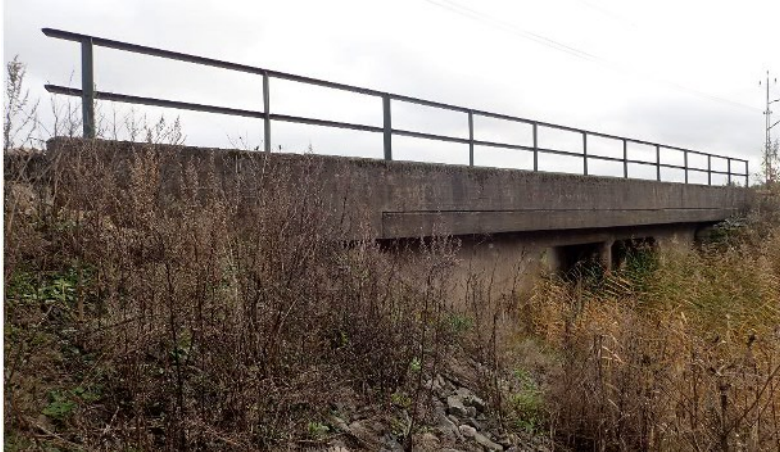
Figur 17 BaTMan ID: 3500-2953-1, järnvägsbro, km 142+620, byggd 1952
