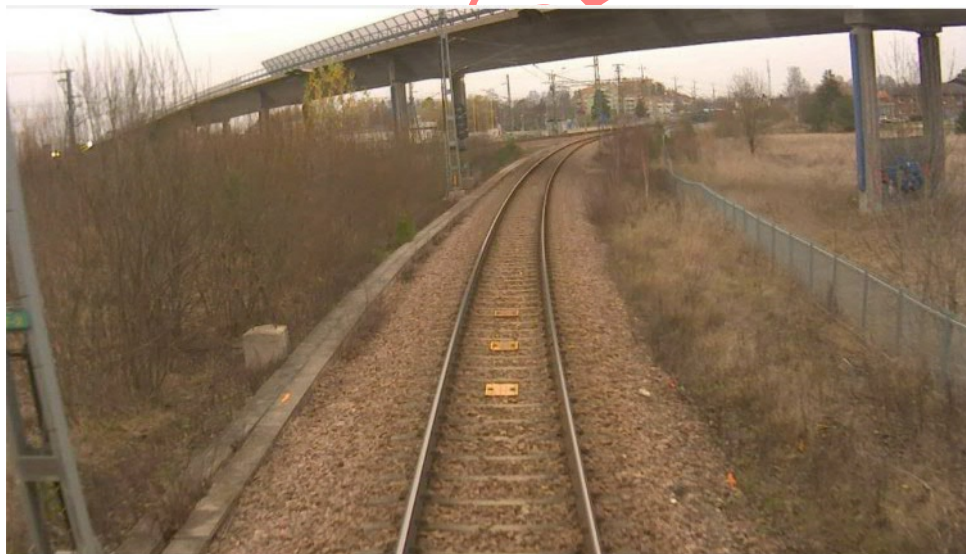
Figur 39 Ny växel, EV-60E-1200-1:18,5 anläggs i rakspår vid ca 216+556 mot Strömsholm
