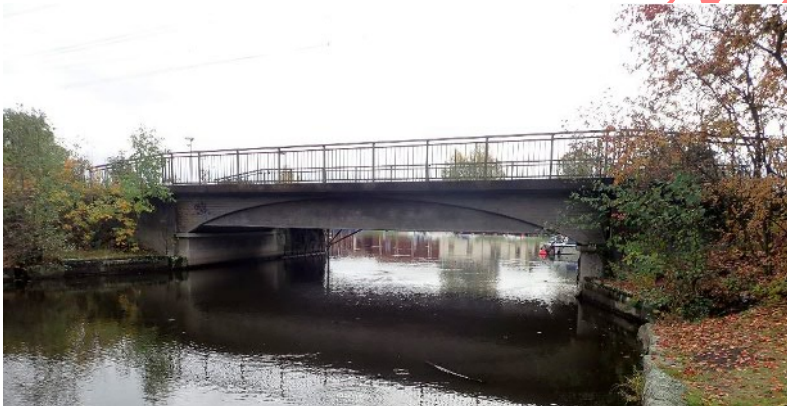
Figur 18 BaTMan ID: 3500-2954-1, järnvägsbro, km 142+620, byggd 1995
