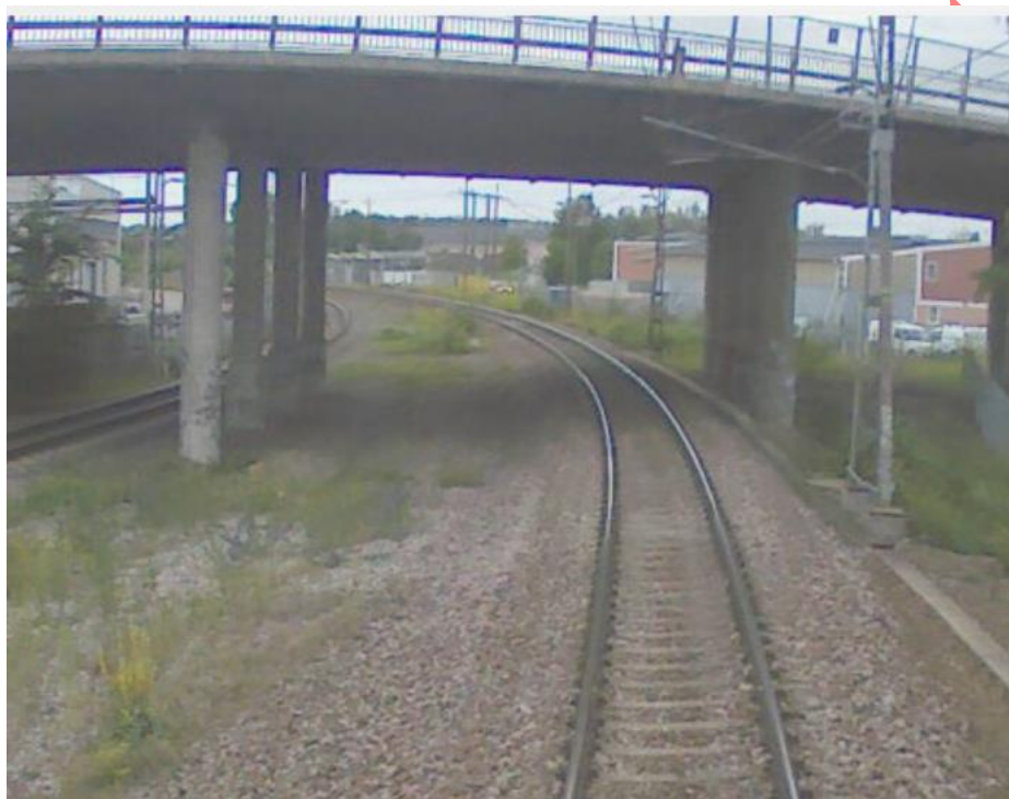
Figur 66 Vägbro (BaTMan ID:19-388-1)
