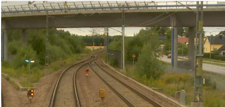
Figur 49 Vägbro (BaTMan ID:19-841-1)
