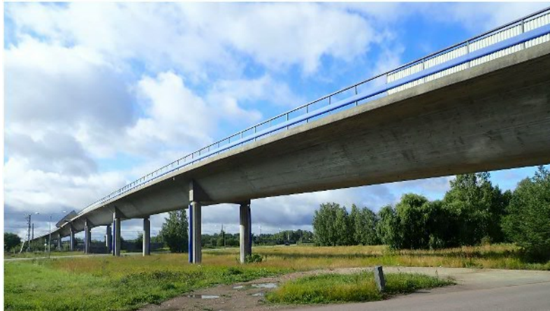
Figur 12 BaTMan ID: 19-841-1, vägbro, ca km 130+803, byggd 1996
