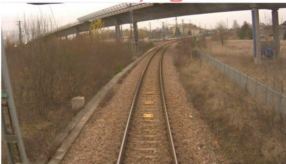
Figur 43 Ny växel, EV-60E-1200-1:18,5 anläggs i rakspår vid ca 216+556 mot Strömsholm
