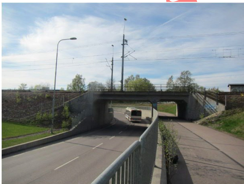
Figur 9 BaTMan ID: 3500-5364-1, järnvägsbro, km 129+873, byggd 2006
