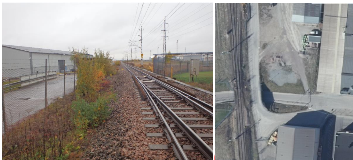
Figur 67 Järnvägsbro (BaTMan ID:3500-3522-1)
