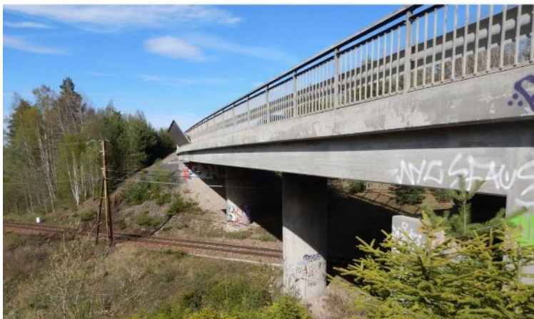
Figur 25 BaTMan ID: 19-21-1, vägbro, ca km 338+731, byggd 1940
