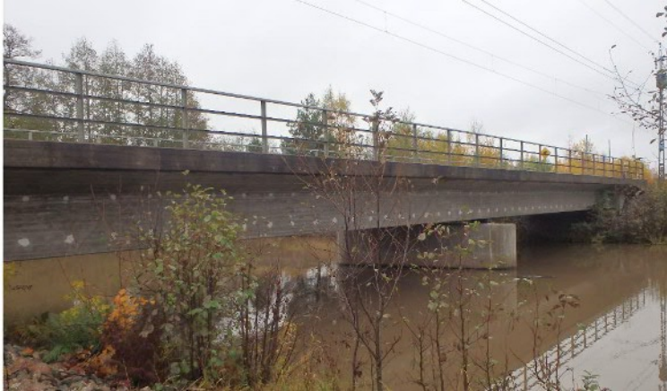
Figur 24 BaTMan ID: 3500-3521-1, järnvägsbro, km 340+32, byggd 1994
