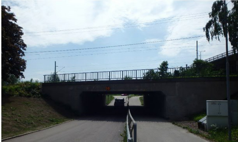
Figur 19 BaTMan ID: 3500-4793-1, järnvägsbro, km 345+005, byggd 1964
