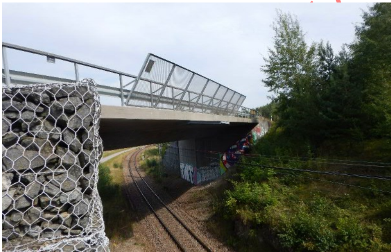
Figur 16 BaTMan ID: 19-824-1, vägbro, ca km 141+610, byggd 1993
