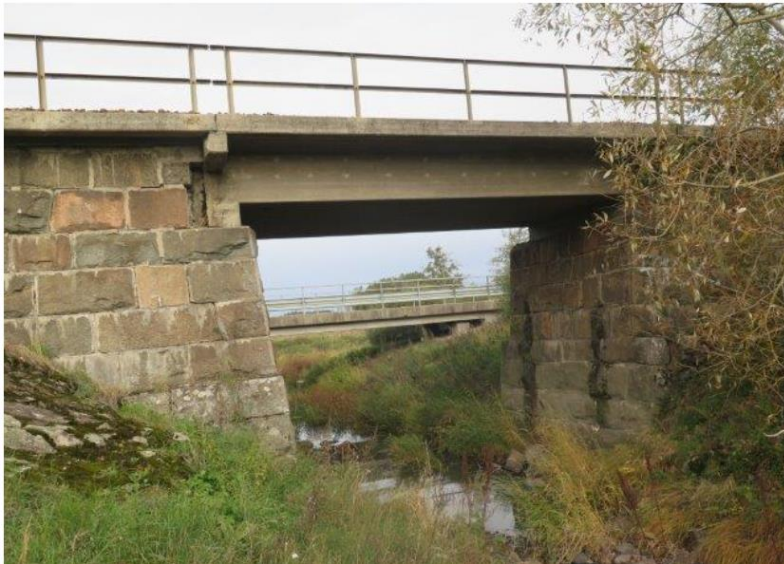
Figur 15 BaTMan ID: 3500-2952-1, järnvägsbro, km 141+000, byggd 1873
