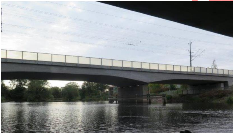
Figur 11 BaTMan ID: 3500-5473-1, järnvägsbro, km 130+511, byggd 2006
