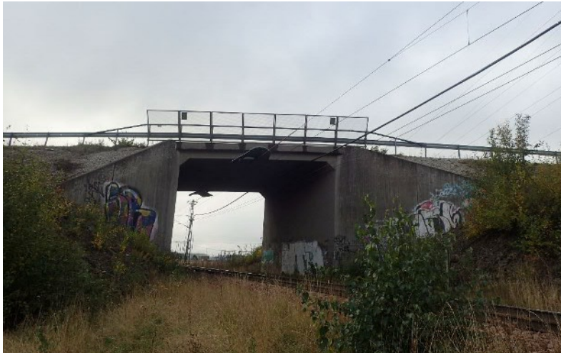
Figur 22 BaTMan ID: 19-819-1, vägbro, ca km 343+578, byggd 1995
