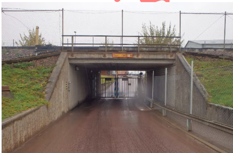
Figur 21 BaTMan ID: 3500-3522-1, järnvägsbro, km 344+383, byggd 1975
