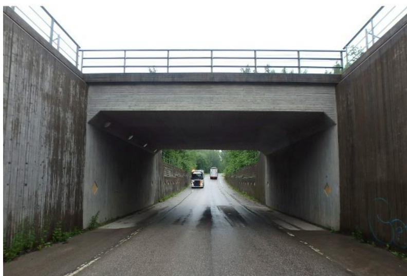
Figur 27 BaTMan ID: 3500-4790-1, järnvägsbro, km 336+170, byggd 1995
