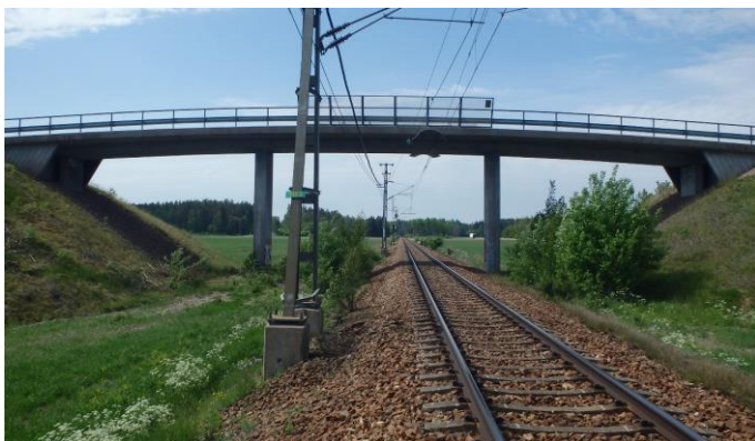
Figur 50 Vägbro (BaTMan ID:3501-6145-1)
